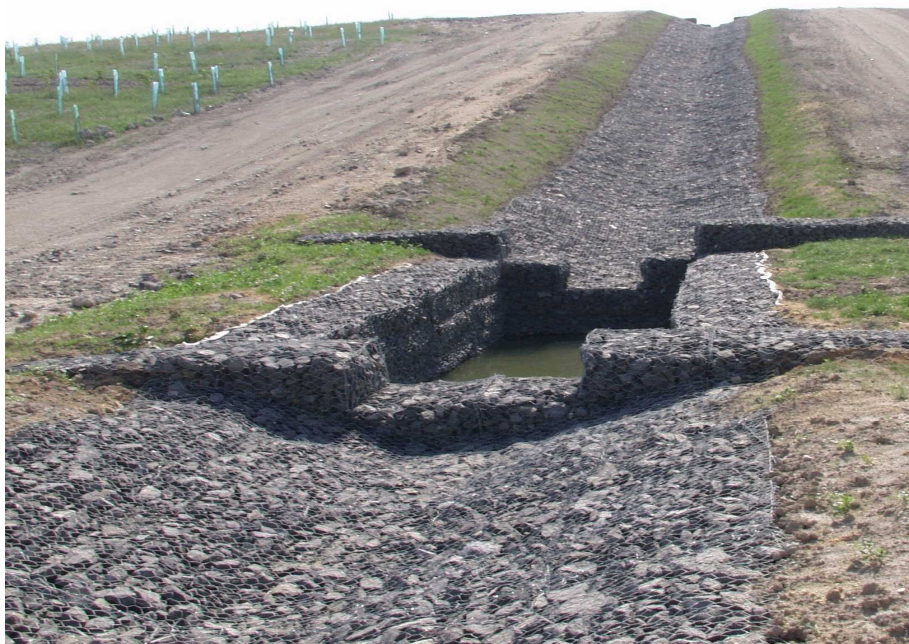
Fot. 3. Rów odwadniający siatkowo-kamienny [fot. Marcinonis, 2005]
