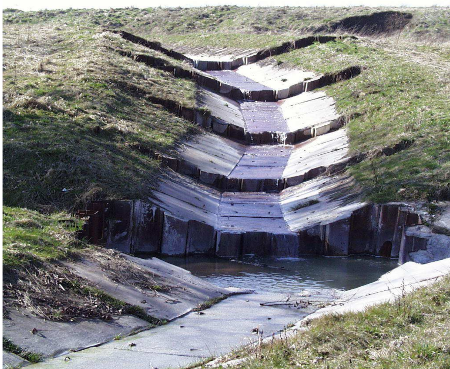
Fot. 4. Rów odwadniający umocniony elementami betonowymi [fot. Marcinonis, 2005]
