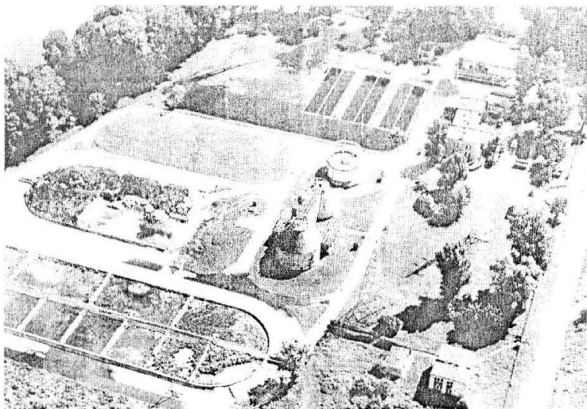
Oczyszczalnia ścieków m. Głogów.
