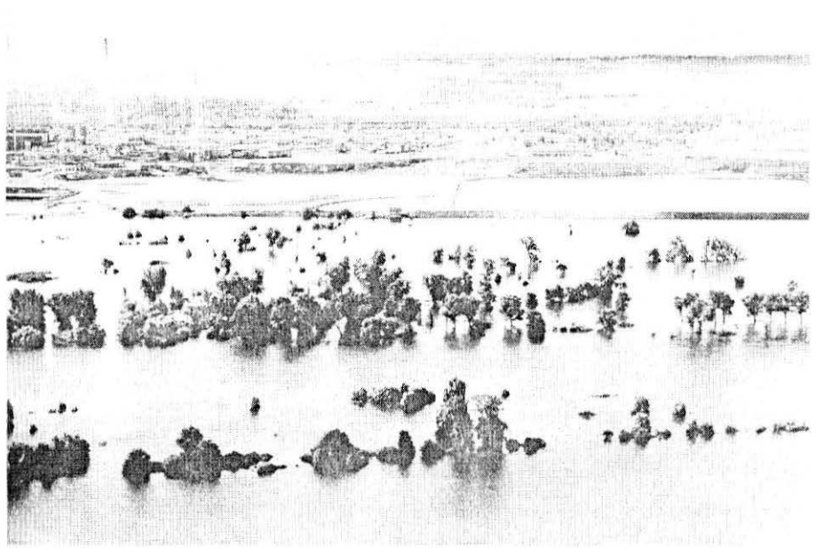
Huta Głogów – fragment. Na planie pierwszym terasa zalewowa Odry, dalej stawy osadowe z mokrego odpylania gazów gardzielowych (28 lipiec 1997), fot. aut.
