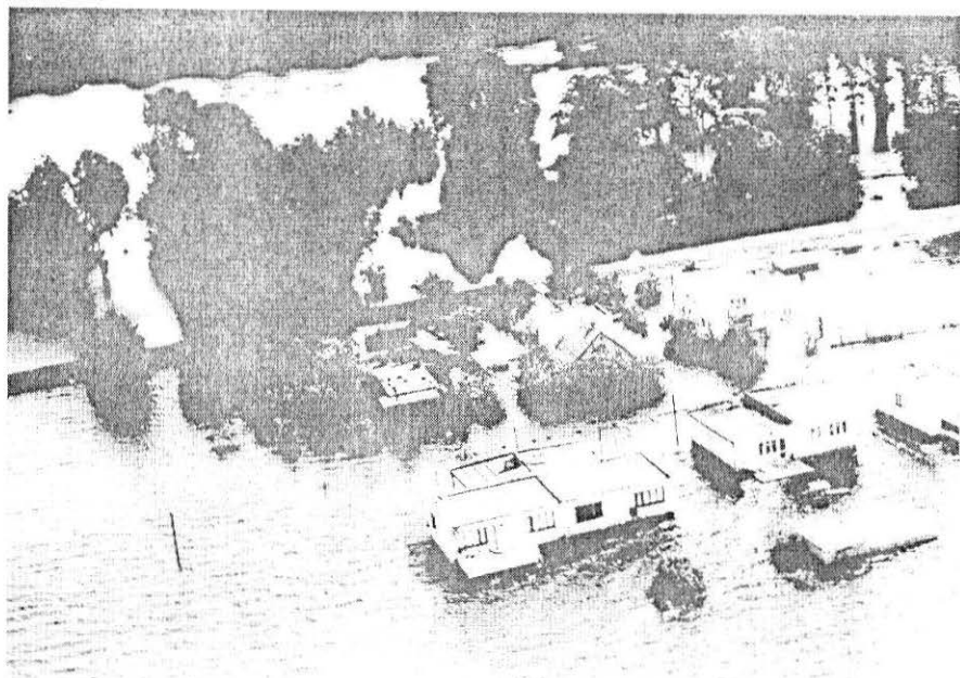
Stara Wieś – budowa osiedla mieszkaniowego w bezpośrednim sąsiedztwie walu przeciwpowodziowego (28 lipiec 1997), fot. aut.
