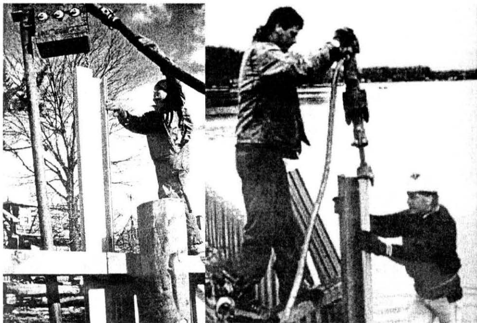
Rys. 3 Montaż grodziec C_LOC przy wykorzystaniu wibromłota
