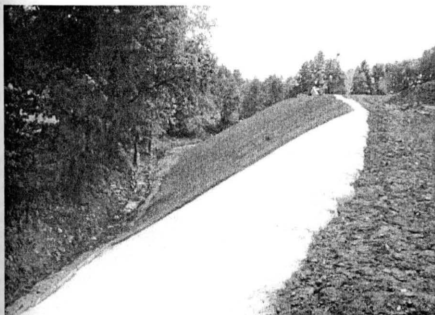
Rys. 2 Układanie warstwy ochronnej na rozłożonej macie bentonitowej
