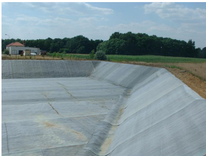
Fot. 1. Bentomat jako element systemu uszczelniającego składowiska odpadów
