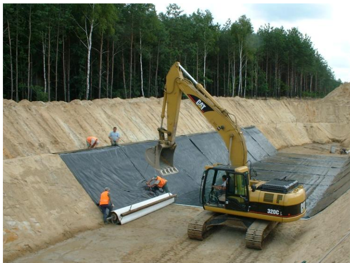
Fot. 3. Uszczelnienie zbiornika odparowującego Bentomatem laminowanym folią PE
