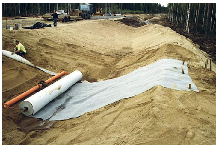
Fot. 4. Ochrona gruntu pod korpusem drogowym
