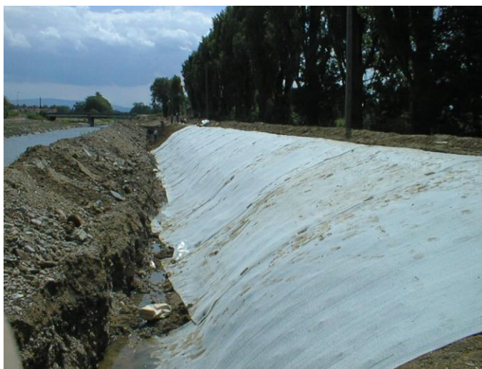
Fot. 2. Jedno z pierwszych zastosowań w Polsce maty bentonitowej do uszczelnienia wału przeciwpowodziowego
