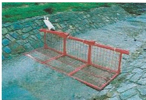
Rys. 2. Przenośne wały przeciwpowodziowe typu PPH070 [Reoamos 2010]
