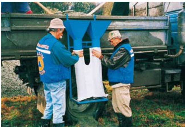
Rys. 7. Propylenowe dwukomorowe worki przeciwpowodziowe [Reoamos 2010] Fig. 7. Polypropylene doublechamber sand bags [Reoamos 2010]
