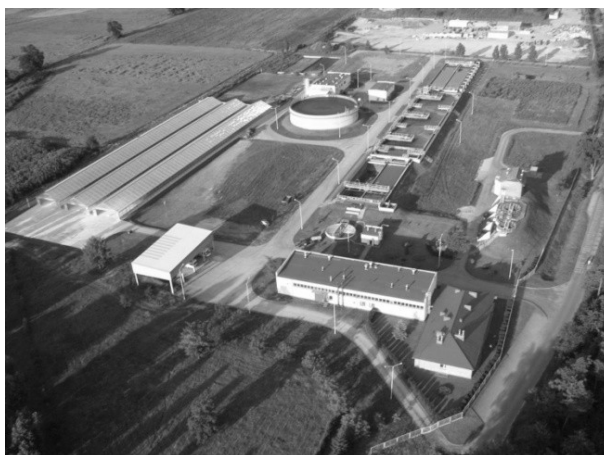
Fot. 1. Widok na oczyszczalnię Złota Struga Phot. 1. View of the Złota Struga WWTP
