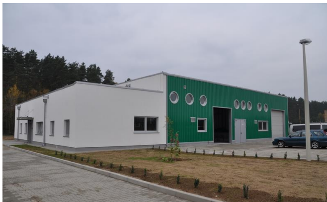
Fot. 1. Widok na oczyszczalnię ścieków w Gronowie Phot. 1. View of the wastewater treatment plant in Gronowo
