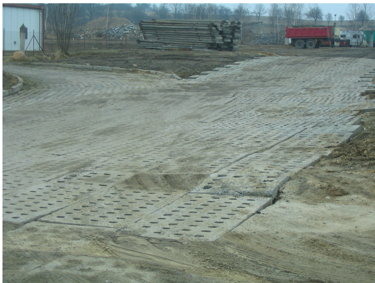
Fot. 2. Fragment utworzonej drogi dojazdowej Phot. 2. Excerpt created access Road
