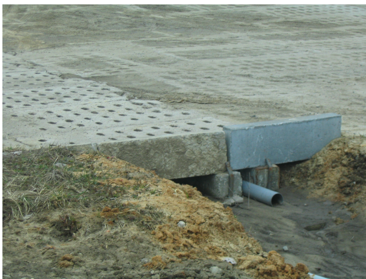
Fot. 3. Sposób wykonania przepustu drogowego Fig. 3 The type of road culvert
