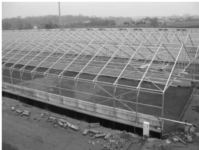
Fot. 1. Widok na hale suszarni solarnej w Żarach w czasie robót montażowych (fot. autor)
