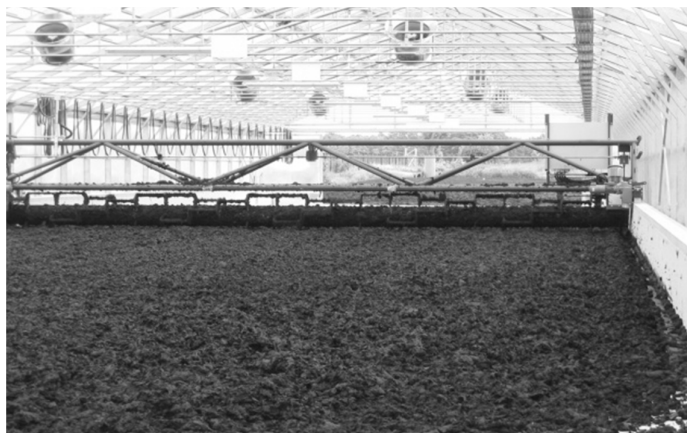
Fot.2. Widok_hali z przewracarką osadów ściekowych w czasie rozruchu technologicznego (fot. autor)
