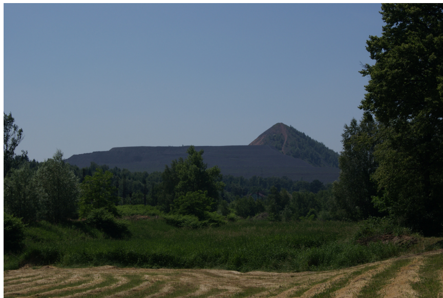
Fot. 3. Widok na obiekt od strony wschodniej. Źródło: J. Kamyk Phot. 3. View of the structure form the east. Source: J. Kamyk
