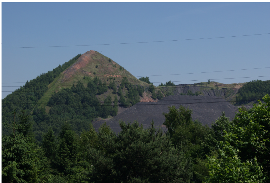
Fot. 2. Widok na obiekt od strony zachodniej. Źródło: J. Kamyk Phot. 2. View of the structure form the west. Source: J. Kamyk
