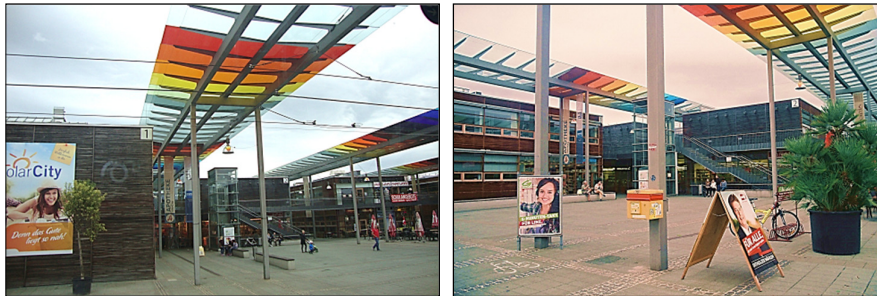
Fot. 4-5. Usługowe Centrum „solarCity”, proj. Auer + Weber + Architekten, Niemcy [Wojtyszyn 2015] Phot. 4-5. Services Center „solarCity”, proj. Auer + Weber + Architekten, Niemcy [Wojtyszyn 2015]
