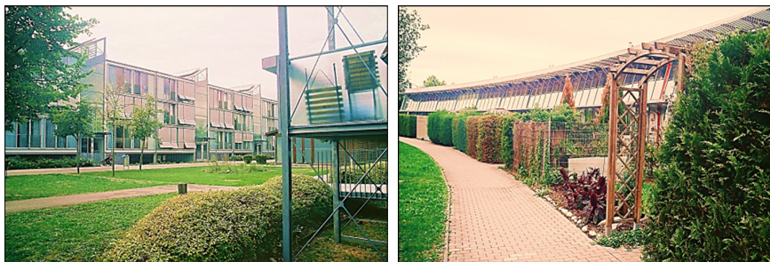
Fot. 6 i 7. Budynki mieszkalne „solarCity”: na lewo proj. Herzog + Partner, Niemcy, na prawo proj. Richard Rogers Partnership, Anglia [Wojtyszyn 2015] Phot. 6 i 7. Housing "solarCity": to the left – proj. Herzog + Partner, Germany, to the right – proj. Richard Rogers Partnership, England [Wojtyszyn 2015]
