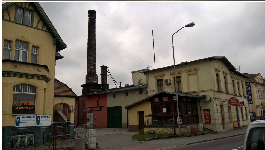
Fot. 4. Budynki fabryczne Bohr, Brunnenbau und Wasserversorgungs AG po renowacji Phot. 4. Factory buildings of Bohr, Brunnenbau und Wasserversorgungs AG after the renovation processes
