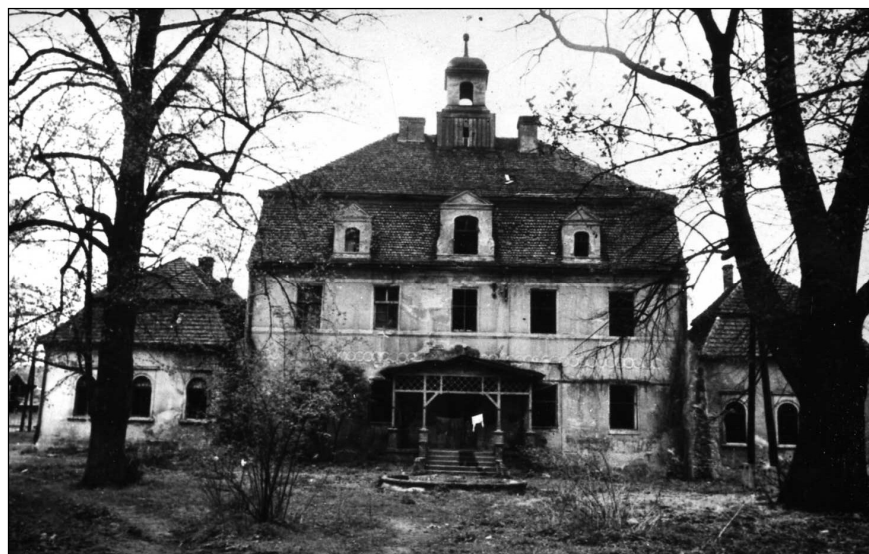
Fot. 3. Pałac – elewacja południowa, stan z 1959 r. [Kąsinowska 1978] Phot. 3. Palace – the southern elevation, state in 1959 [Kąsinowska 1978]
