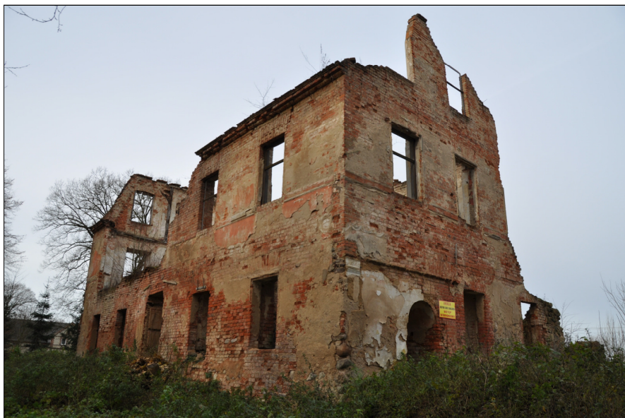
Fot. 6. Włostów, pałac. Widok od południowego wschodu [Eckert 2015] Phot. 6. Włostów, palace. A view from the south-east [Eckert 2015]
