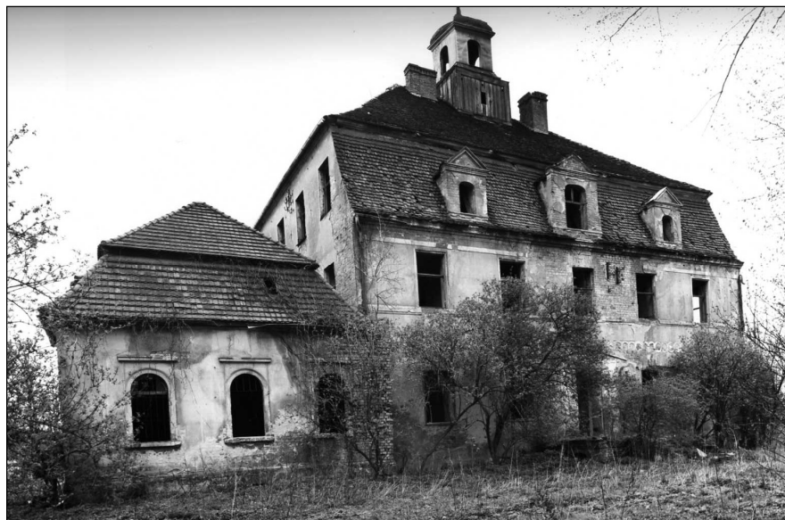
Fot. 4. Pałac – elewacja południowa, stan z 1978 r. [Kąsinowska 1978] Phot. 4. Palace – the southern elevation, state in 1978 [Kąsinowska 1978]
