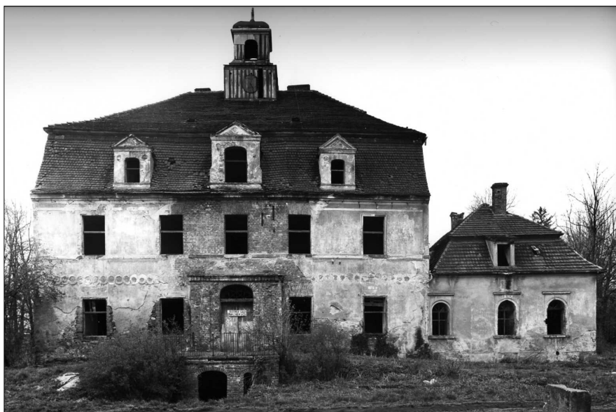
Fot. 5. Pałac – fasada, stan z 1978 r. [Kąsinowska 1978] Phot. 5. Palace facade in the 1978 [Kąsinowska 1978]
