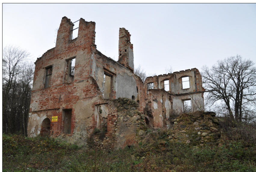
Fot. 7. Włostów, pałac. Widok od wschodu [Eckert 2015] Phot. 7. Włostów, palace. A view from the east [Eckert 2015]
