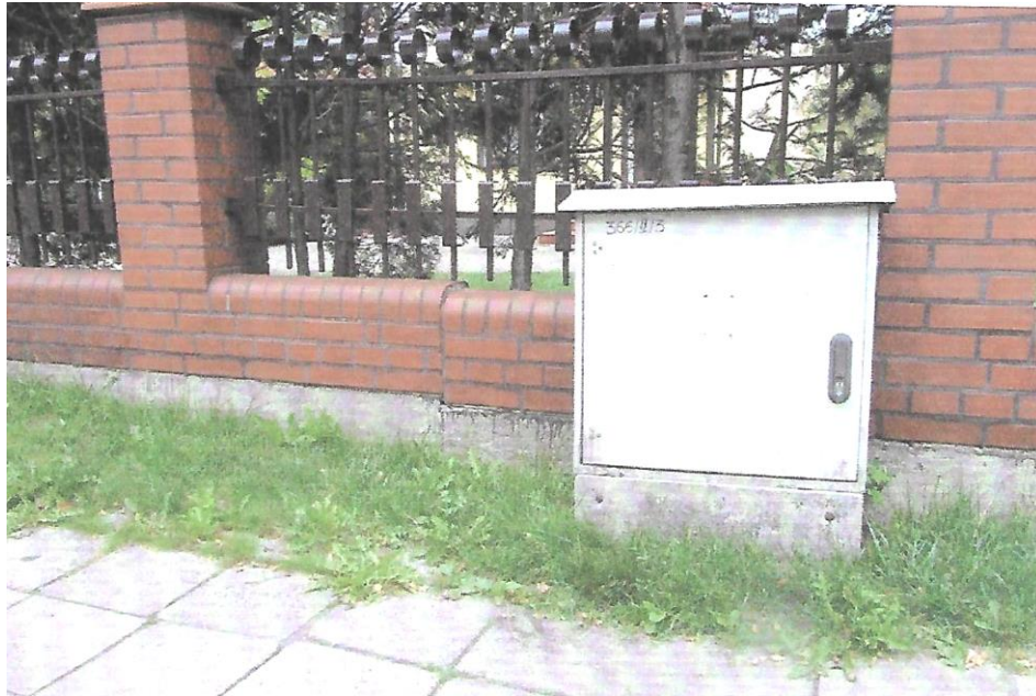
Fot. 2. Awaria ogrodzenia - Świebodzin, dz. nr 166/5 (2004) Photo 2. Fencing failure - Świebodzin, land plot no. 166/5 (2004)
