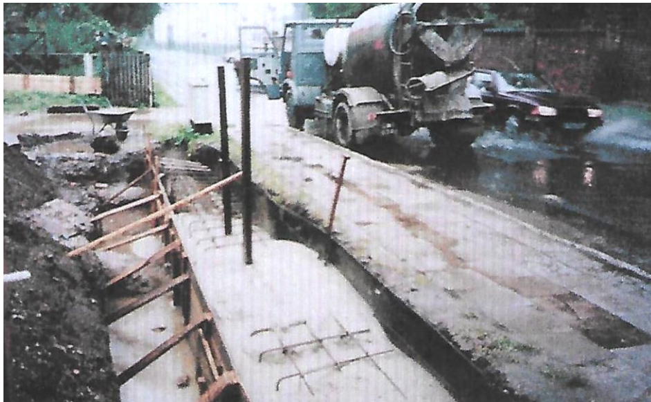
Fot. 1. Prace wzmacniające podłoże gruntowe - Świebodzin, dz. nr 166/5 (2002r.)
