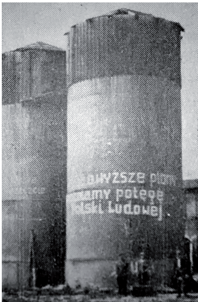
Il. 4. Silosy będące w dyspozycji zielonogórskich PGR-ów i spółdzielni produkcyjnych opatrzone hasłami propagandowymi
