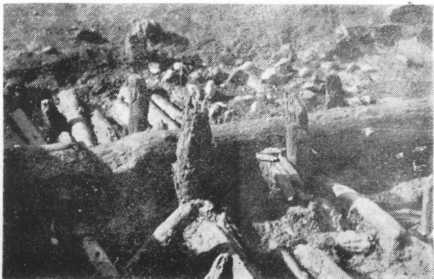
Ryc 20 i 21. Konstrukcje drewniane wału obronnego (Pszczew, pow. Międzyrzecz, stan 2)
