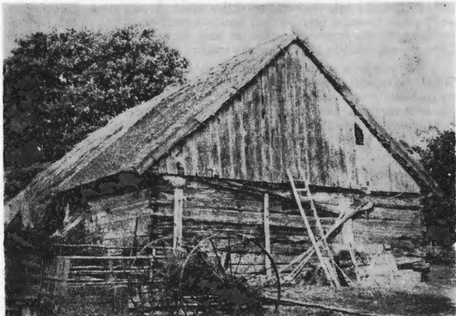
7. Stodola drewniana zbudowana „na węgiel”, Rybojady pow. Międzyrzecz, (fot. B. Kołodziejska)
