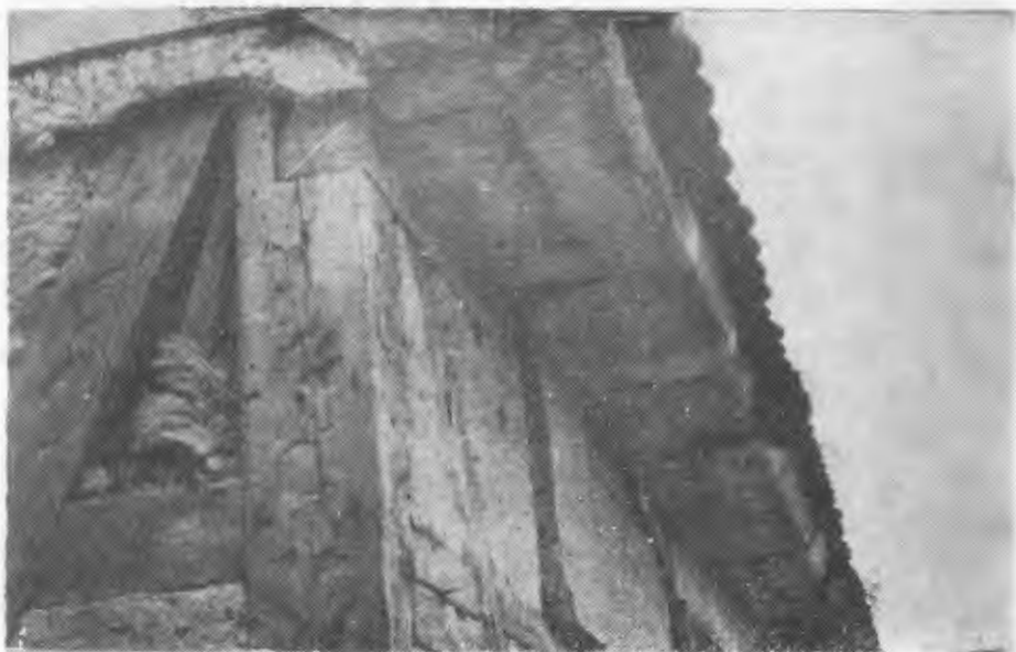
12. Fragment konstrukcji domu ryglowego, okap również ryglowy, Podmokle Wielkie pow. Sulechów, (fot. B. Matuszewska)
