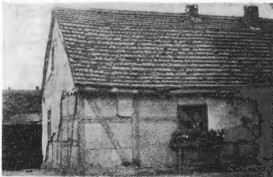
10. Fragment domu o konstrukcji ryglowej, Podmokle Wielkie pow. Sulechów (fot. B. Matuszewska)
