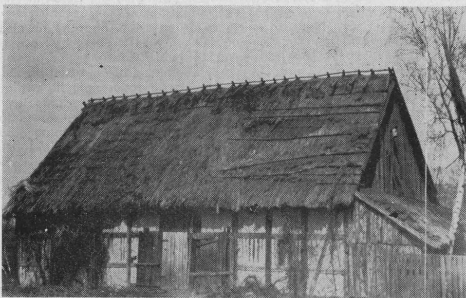
Kargowa. Stodoła, której ściany budowane są w tzw. strychulec (fot. autor)
