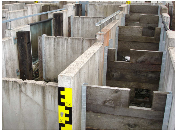
Fig. 1. Baffle fishway in Schleusingen/Gernany (photo Tymiński)
