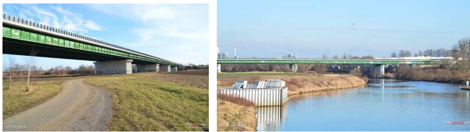
Fig. 4. Bridge over the Oder river in Rogów Opolski (Poland)
