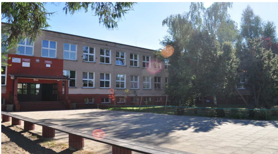
Fot. 1. Elewacja zachodnia budynku szkoły - wejście główne. [N.Rzeszowska] Phot. 1. Western elevation of the school building - main entrance. [N.Rzeszowska]
