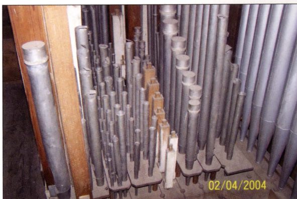
Przykłady uszkodzonych i zniszczonych piszczalek metalowych i drewnianych. Fot. Cz. Chrobak, 2004.
