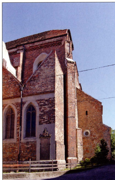
Kaplica Wszystkich Świętych przy nawie północnej i kruchta przy ścianie zachodniej.
