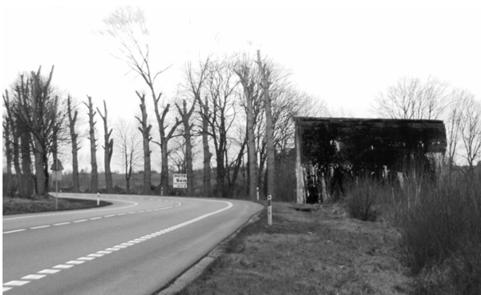
5. Jeden z filarów niemieckiej autostrady, wybudowany ok. 1943 roku, został rozebrany podczas budowy autostrady A2 w 2009 roku. Stan z 2008 roku
