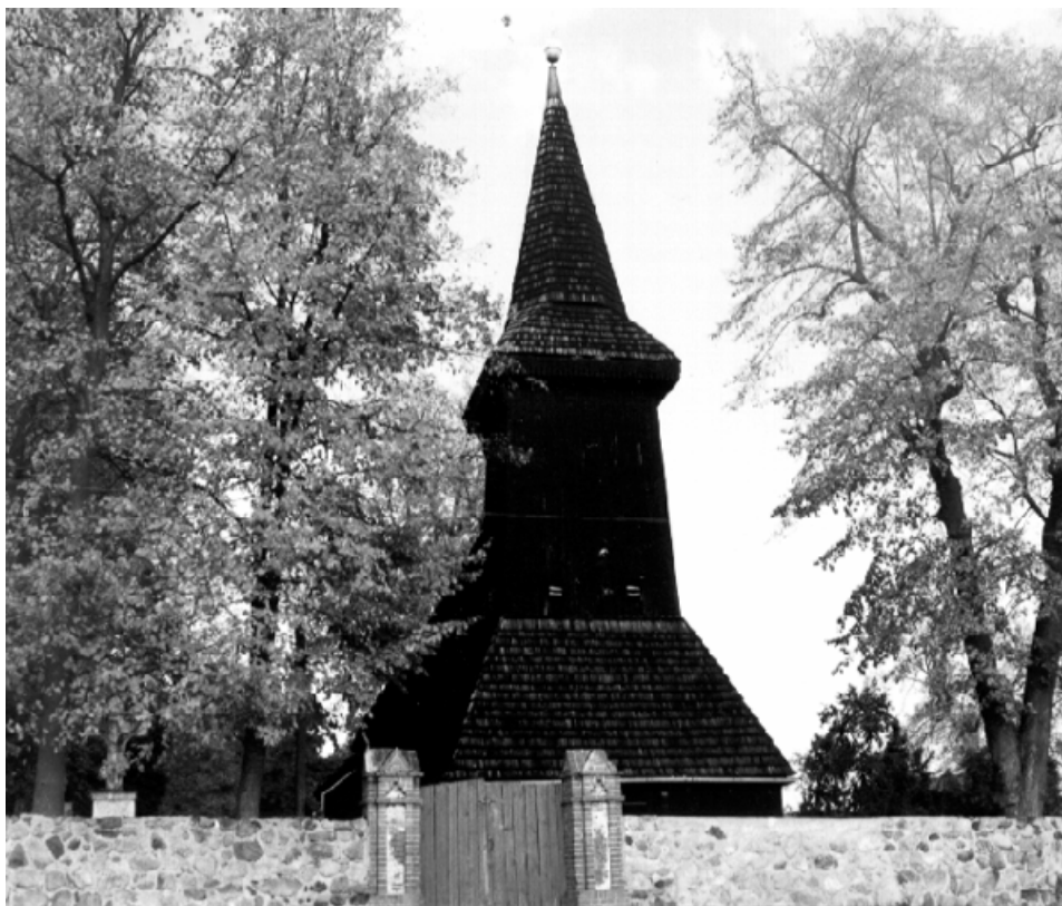
14. Kościół w Łagowcu, 1996 rok, fotografia Ryszarda Patorskiego
