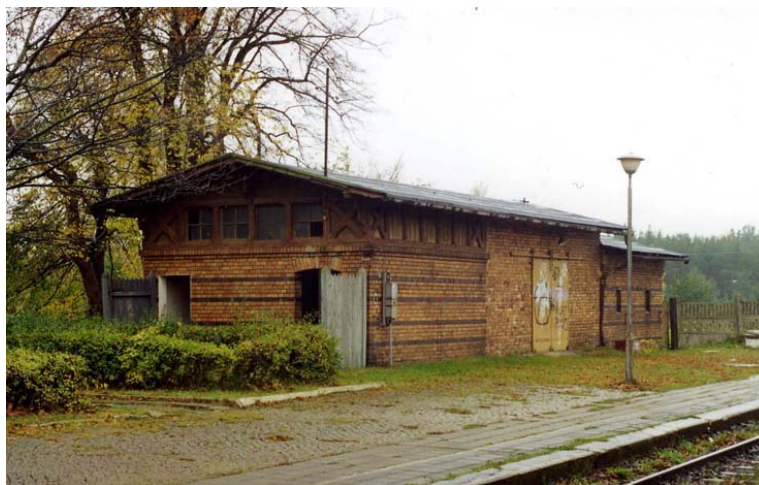
Fot. 12. Nowogród Bobrzański – Osiedle – szalety peronowe.
