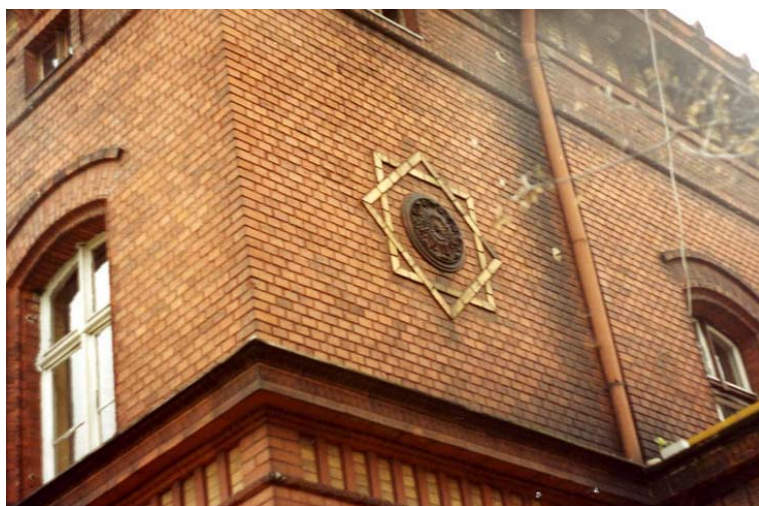
Fot. 8. Jankowa Żagańska – ceramiczny detal na elewacji budynku stacyjnego.
