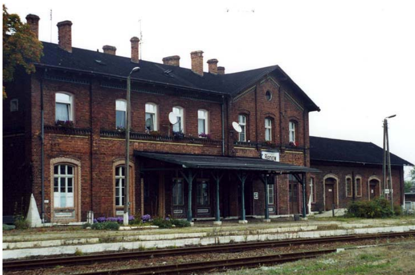
Fot. 5. Budynek stacji w Bieniowie.
