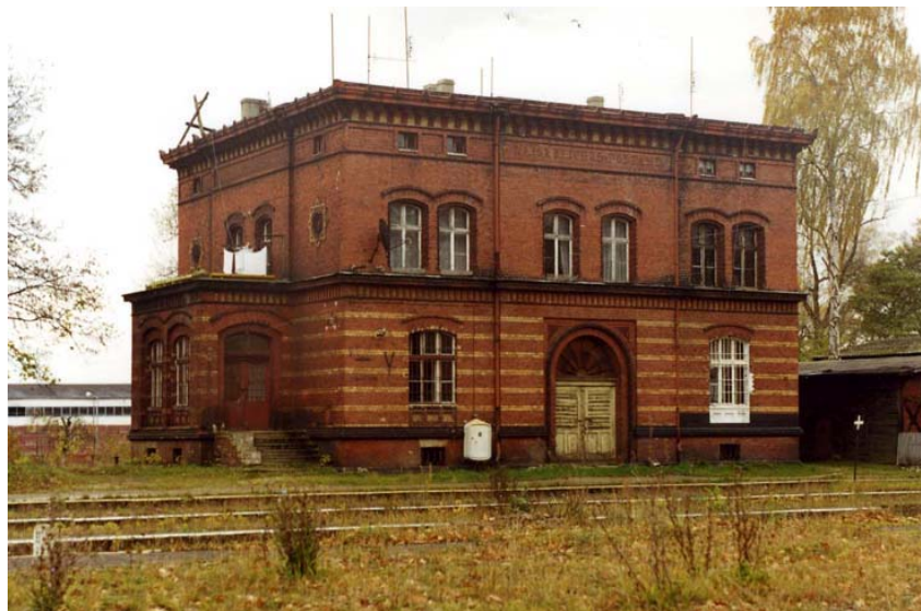
Fot. 6. Jankowa Żagańska – budynek stacji.
